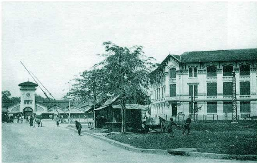
Một góc toà nhà Sở Hỏa xa Đông Dương chi nhánh phía Nam nhìn ra đường Hàm Nghi, phía bên có rào chắn cho đường sắt nội đô chạy ngang qua chợ Bến Thành (Nguồn: Manhhaiflickr)
