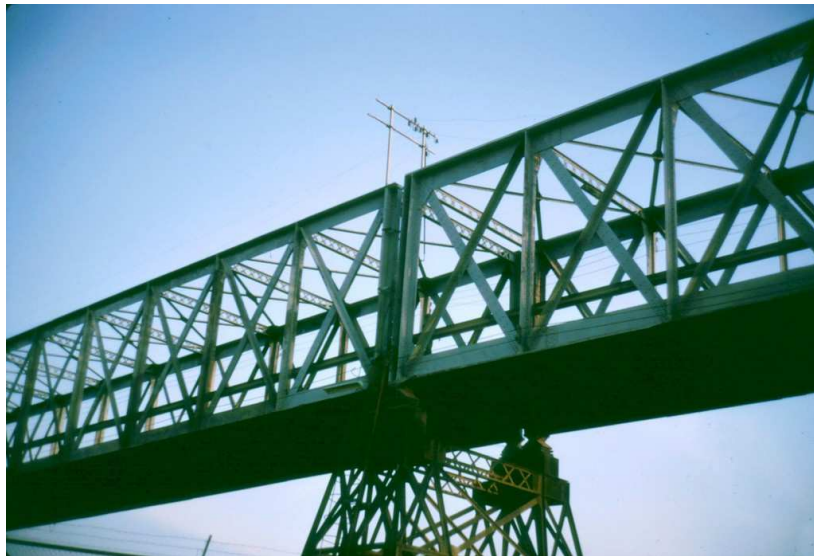
Cầu Bến Lức địa danh nổi tiếng của Long An bắc qua sông Vàm Cỏ Đông tại huyện Bến Lức, Long An.
